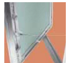
Linka zabezpieczająca przed niekontrolowanym otwarciem. A cable to protect against uncontrolled opening.
